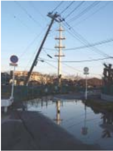
傾いた電柱と水道本管からの漏水
